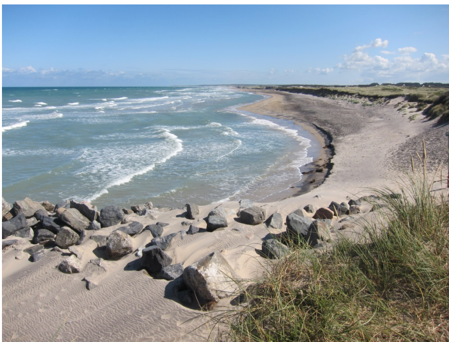
Figur 4: Læsideerosion ved den nordlige høfde, Juli 2015
